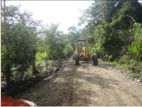
Autogestión con el GAD Provincial en la Ampliación de la Carretera en el Recinto La Milagreña.
