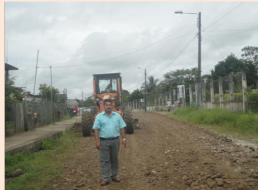
Autogestión con GAD Cantonal para el Arreglo de la Calle del Barrio Bellavista
